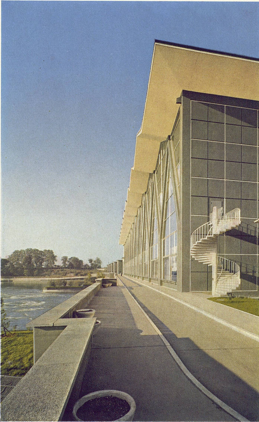
13 Fußgängerweg an der Unterseite des Stauwehrs und Aufgang zur Besuchergalerie Sentier promenade et entrée de la galerie des visiteurs Pedestrians' walk and entrance to the visitors' gallery
