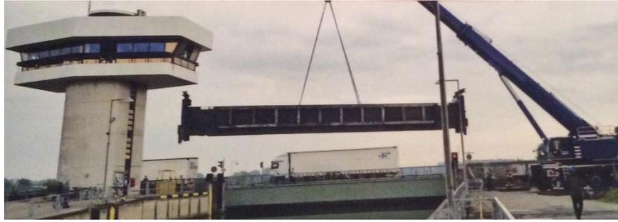
Abbildung 27: Einbau des Stoßschutzes an der Schleuse Iffezheim (Foto: Broschüre Wasser- und Schifffahrtsamt Freiburg)
