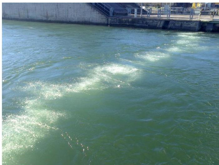
Abbildung 18: Luftblasen ausgelöst durch die Lufteintragsanlage (Foto: Solbrig und Banek)
