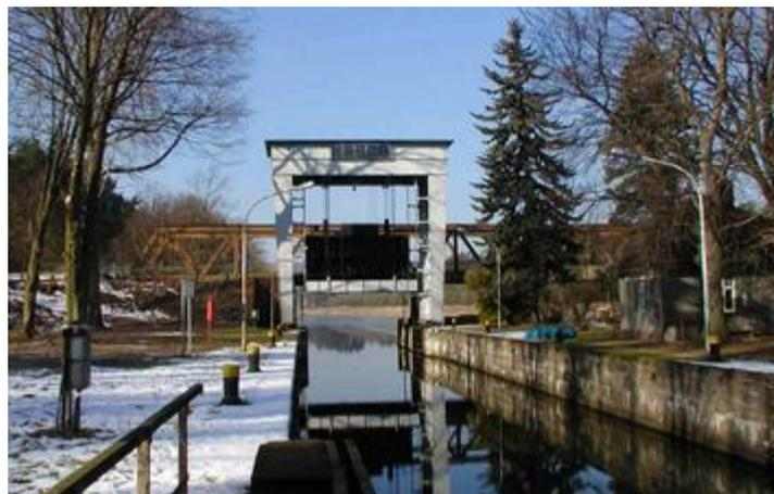
Abbildung 5: Ausführungsart eines Hubtores<sup>6</sup>
