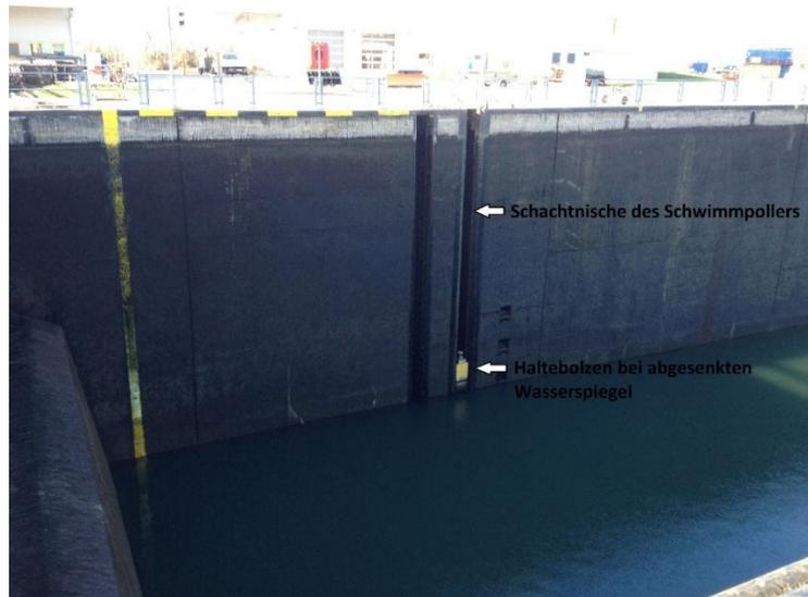
Abbildung 25: Schachtnische des Schwimmpollers (Foto: Solbrig und Banek)
