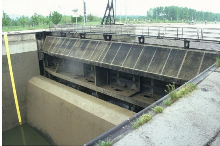
Abbildung 17: Senktor des Oberhauptes aus anderer Perspektive (Foto: Solbrig und Banek)
